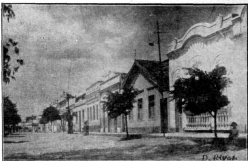
Um trecho da rua João Pessoa
