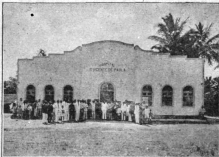
O "Hospital S. Vicente de Paulo", installado no antigo abrigo do mesmo nome, tendo-se aproveitado apenas o principal do velho edificio.
