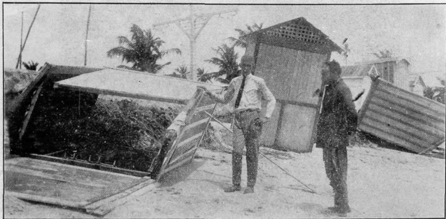
A devastação dos banheiros da praia de Boa-Viagem
