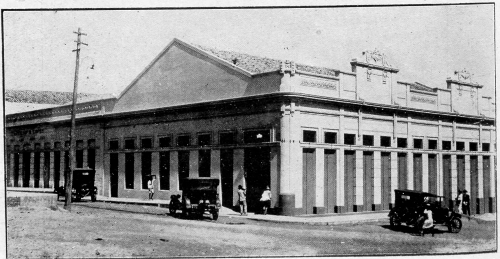
Edificio onde funcionou a Exposição do Café
