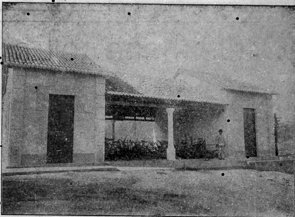
Pavilhão de machinas do campo de sementeira de Caruarú
