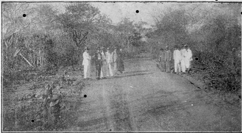
Trecho da Estrada Bodocó a Novo Exú — 54 kilometros
