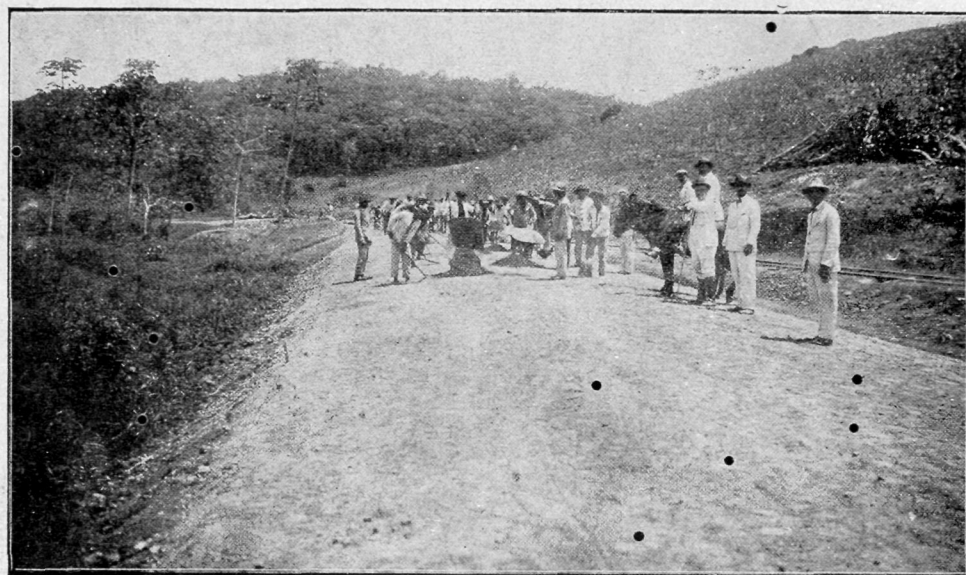
Trecho em construção em Montevideo—Ipojuca
