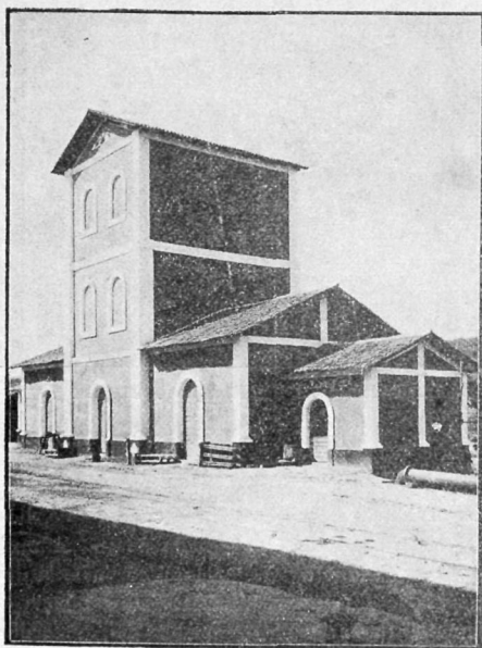
Edificio da fabrica da USGA, em Serra Grande, actualmente sendo augmentado para installação de novos apparatus
