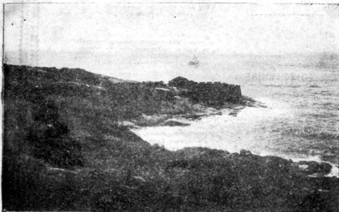
As ruínas do Forte de Nazareth.
