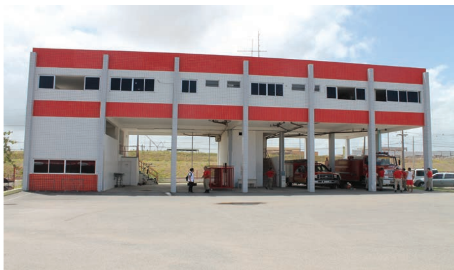
Garagem de viaturas da seção de bombeiros de Suape
