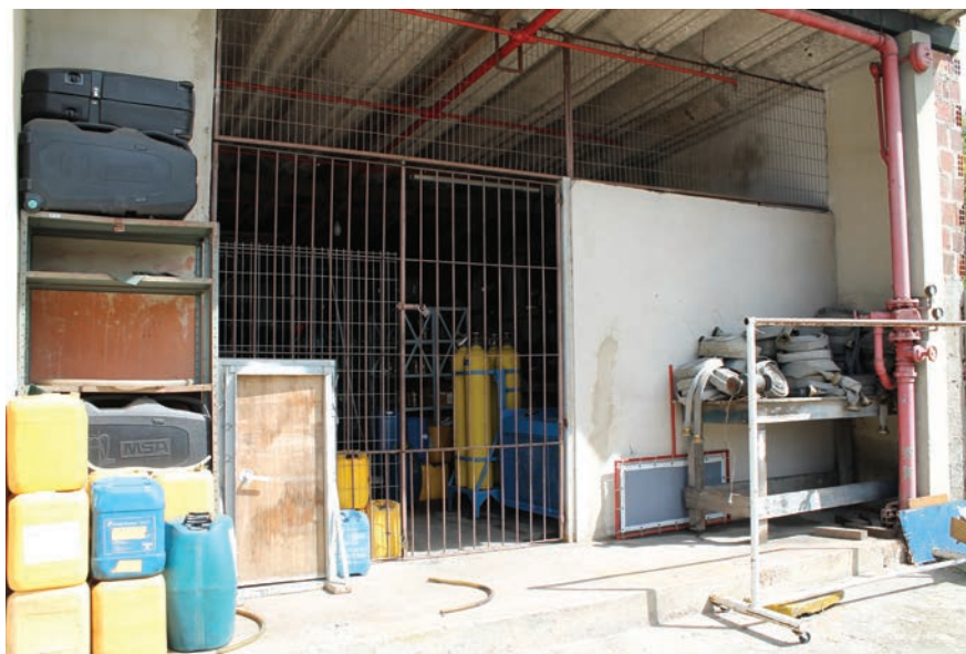
Sala do almoxarifado de equipamentos operacionais
