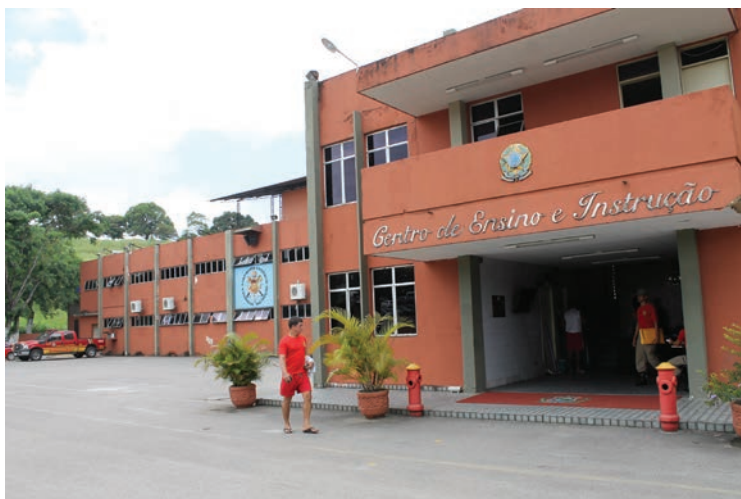
Fachada do Cemeteiro II e entrada da recepção
