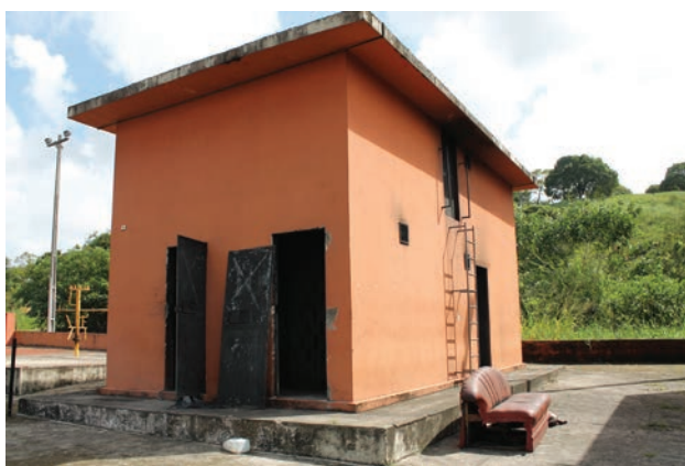
Casa para treinamento de combate a incêndio em ambientes confinados
