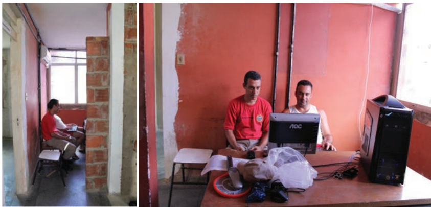
Sala em reforma onde funcionará o novo comando da unidade
