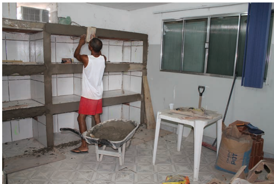
Bombeiro trabalha na reforma da sala de aprovisionamento
