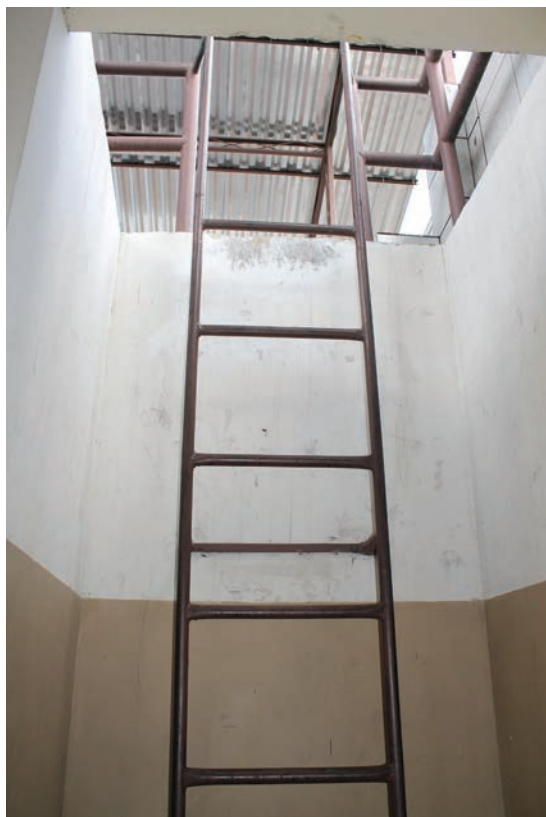
Escada para a estrutura de treinamento em altura
