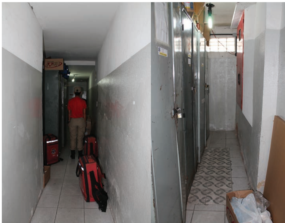
Corredor de acesso ao térreo dispõe de armários pessoais
