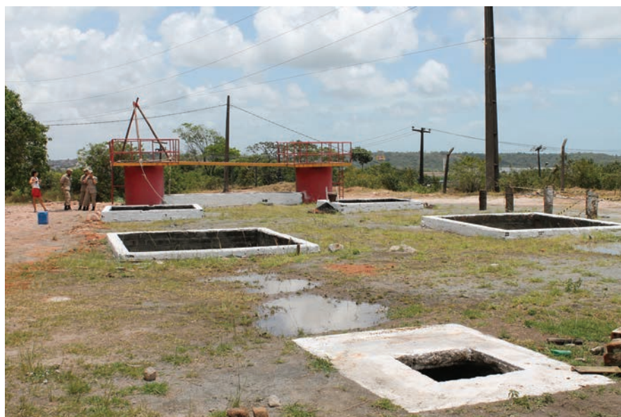
Campo de instrução operacional em tubulações subterrâneas
