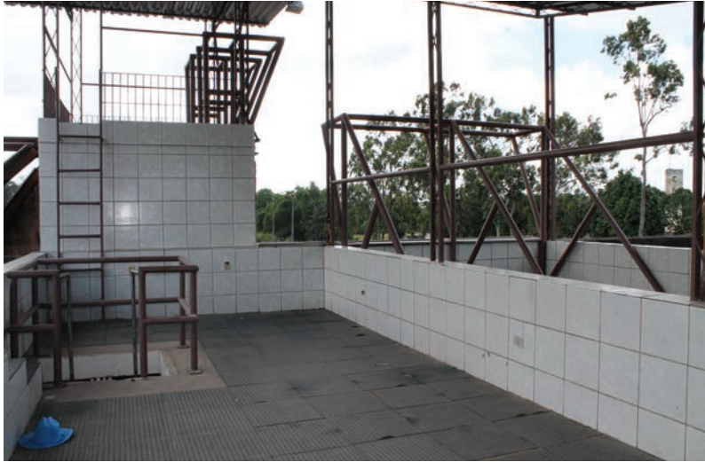
Campo de treinamento de salvamento em altura
