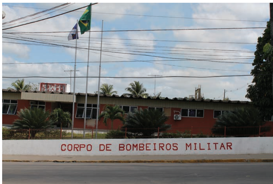
Fachada da unidade descentralizada de bombeiros de São Lourenço de Mata
