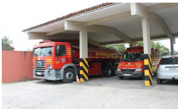
Garagem de viaturas da unidade de bombeiros de Igarassu
