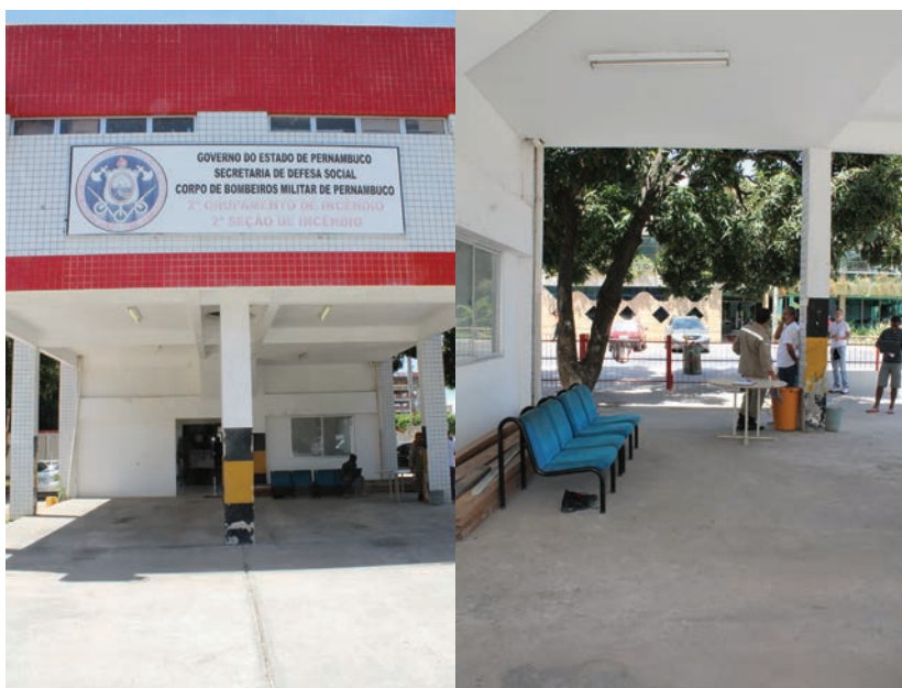
Espaço frontal que serve como garagem de viaturas da unidade
