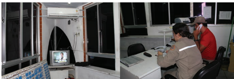
Aspectos da sala da central telefônica do grupamento de atendimento pré-hospitalar
