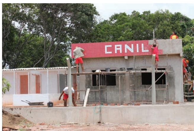
Bombeiros trabalham na construção do canil do GBSAT
