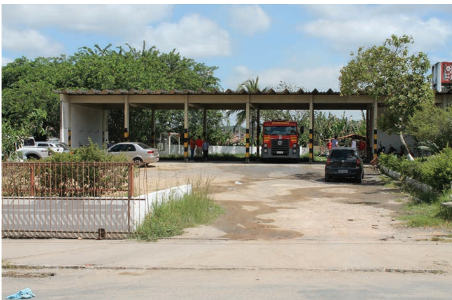
Entrada de veículos e garagem de viaturas da unidade de São Lourenço
