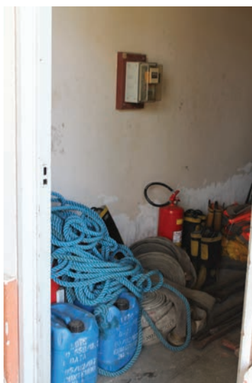
Depósito na antiga casa de força
