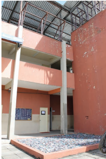
Chão de chinelos de borracha amortece queda
