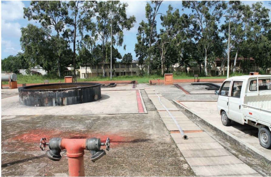
Campo de treinamento da área de combate a incêndio
