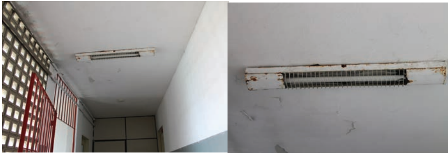
Detalhe do teto do corredor que dá acesso às salas do setor administrativo do 2º GI
