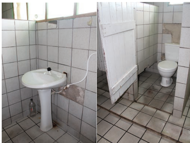
Banheiro do alojamento de cabos e soldados
