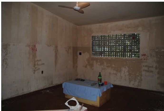
Um dos quartos/celas que se encontra em reforma na unidade
