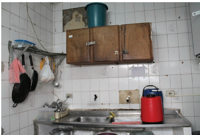
Aspecto interno da cozinha da Casem Recife II
