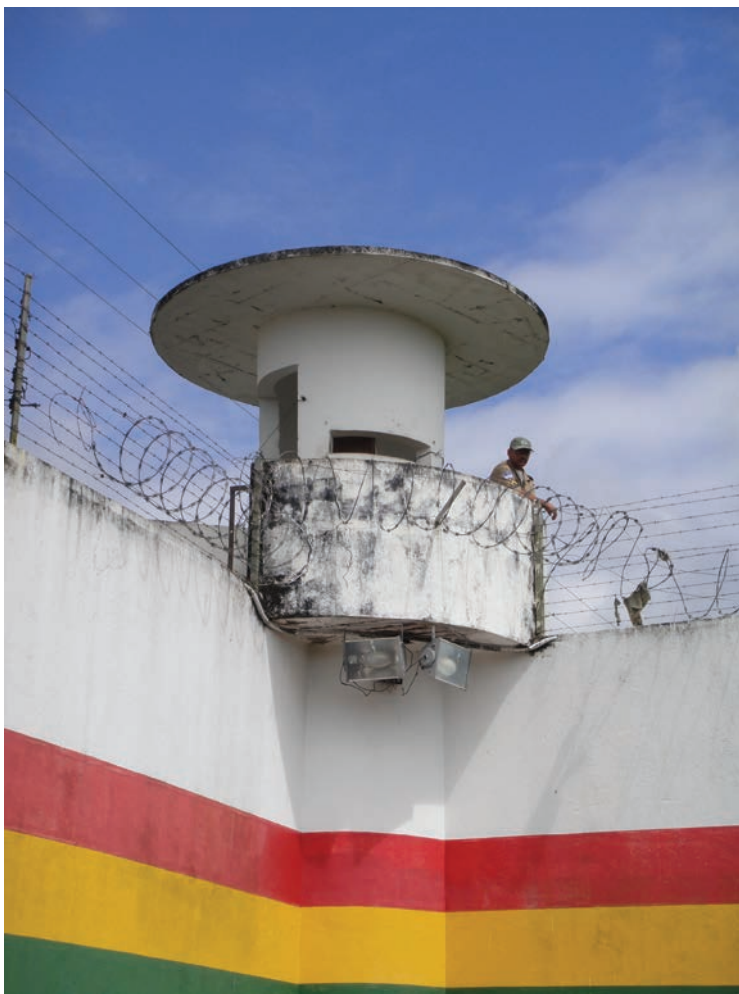
Parte interna da guarita de segurança da unidade
