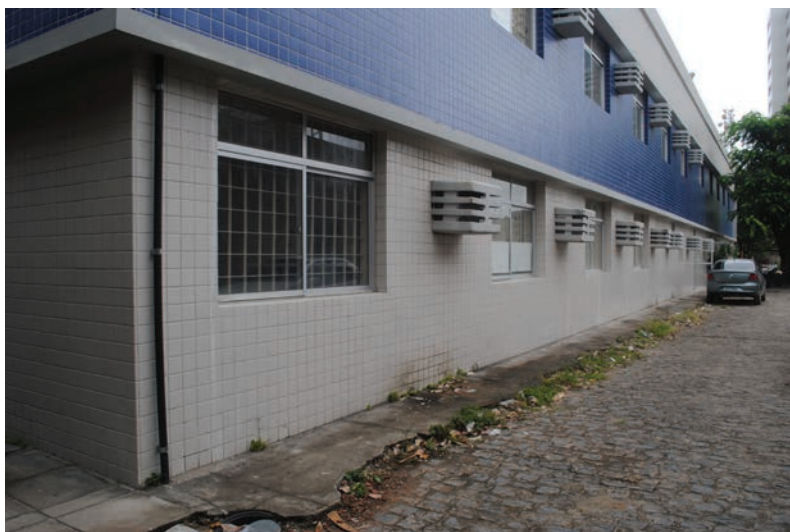
Fachada lateral do prédio onde funciona a Uniai
