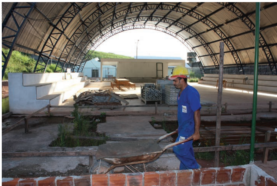
Unidade do Jaboatão dos Guararapes passa por ampliação que inclui quadra de esportes
