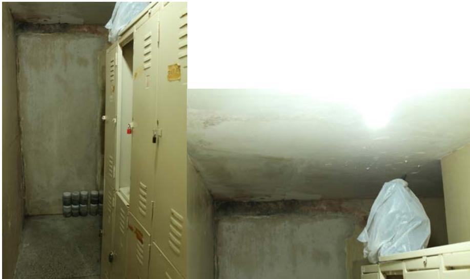
*Imagem 370: Corredor do prédio com armários e marcas de infiltração de água nas paredes.*
