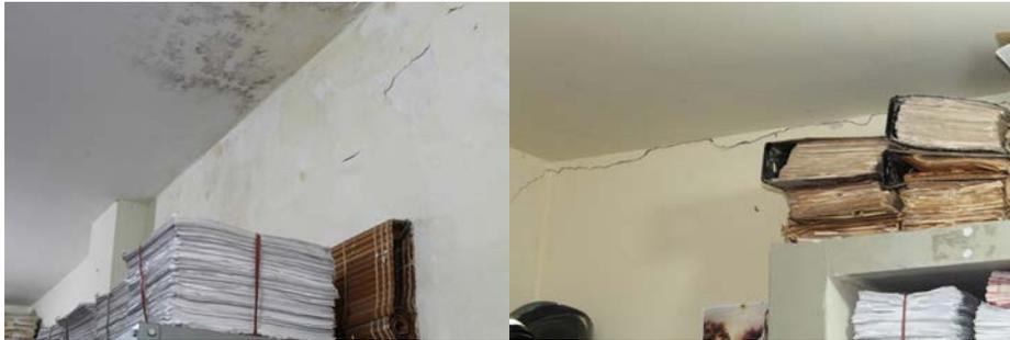
*Imagem 351: Marcas de infiltração de umidade e rachaduras no teto.*
