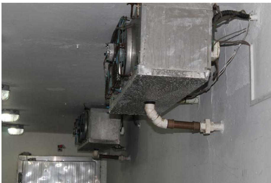
*Imagem 295: Forçadores de ar do sistema de refrigeração da câmara.*
