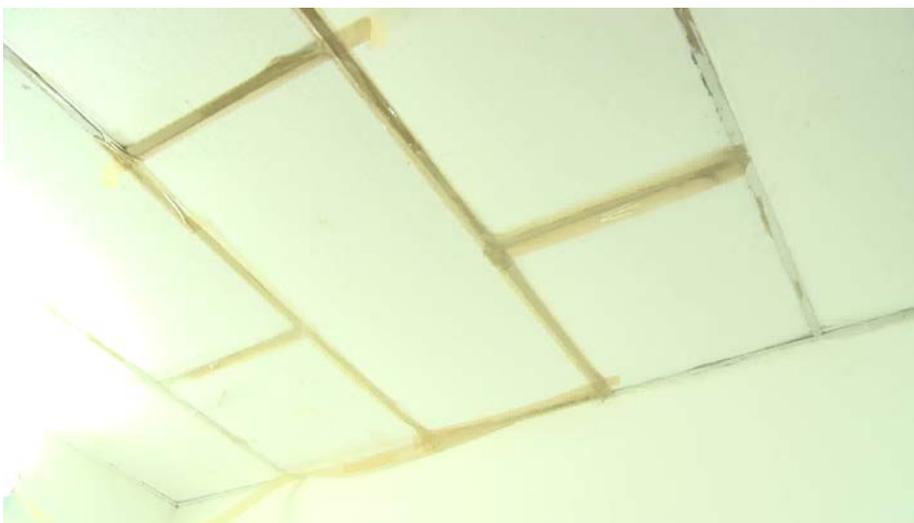
*Imagem 26: Fitas adesivas vedam vãos entre placas de isopor no teto.*
