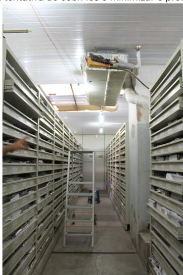
*Imagem 104: Um dos buracos existentes no forro de PVC na área nova do arquivo civil do intituto. Este, no caso, localiza-se sobre um aparelho de ar-condicionado e ilustra as condições que inviabilizam a climatização do local.*
