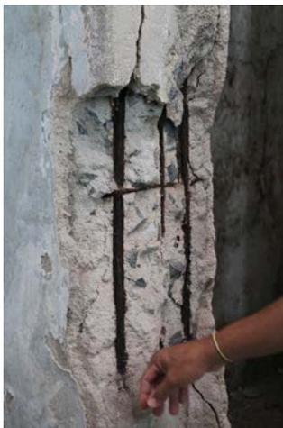
*Imagem 107: Coluna de sustentação do galpão danificada e com vergalhões expostos.*
