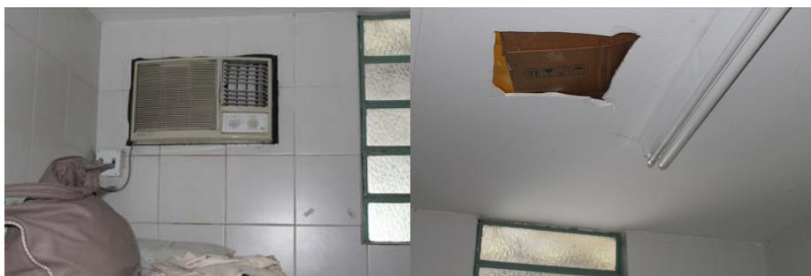
*Imagem 318: Ar-condicionado e buraco no teto do alojamento tampado com pedaços de papelão*
