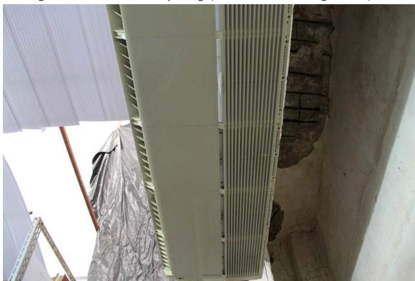
*Imagem 108: Detalhe de falha no teto do arquivo civil localizada sobre outro aparelho de ar condicionado, atrás do qual mais vergalhões da estrutura do galpão estão expostos.*
