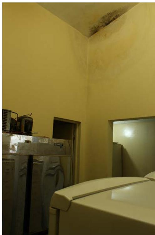
Imagem 367: Refrigeradores instalados no corredor. No teto, marcas de infiltração de água.
