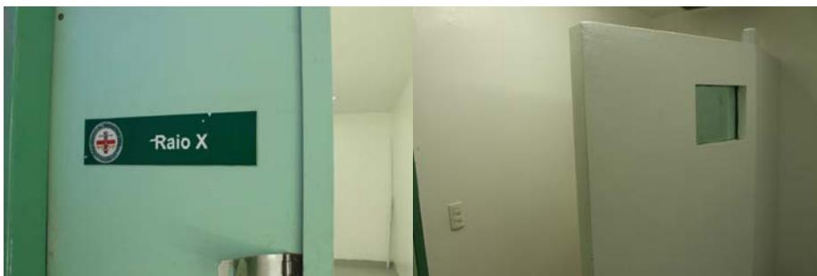
*Imagem 303: Porta da sala do Raio-X e parede de proteção contra radiação.*
