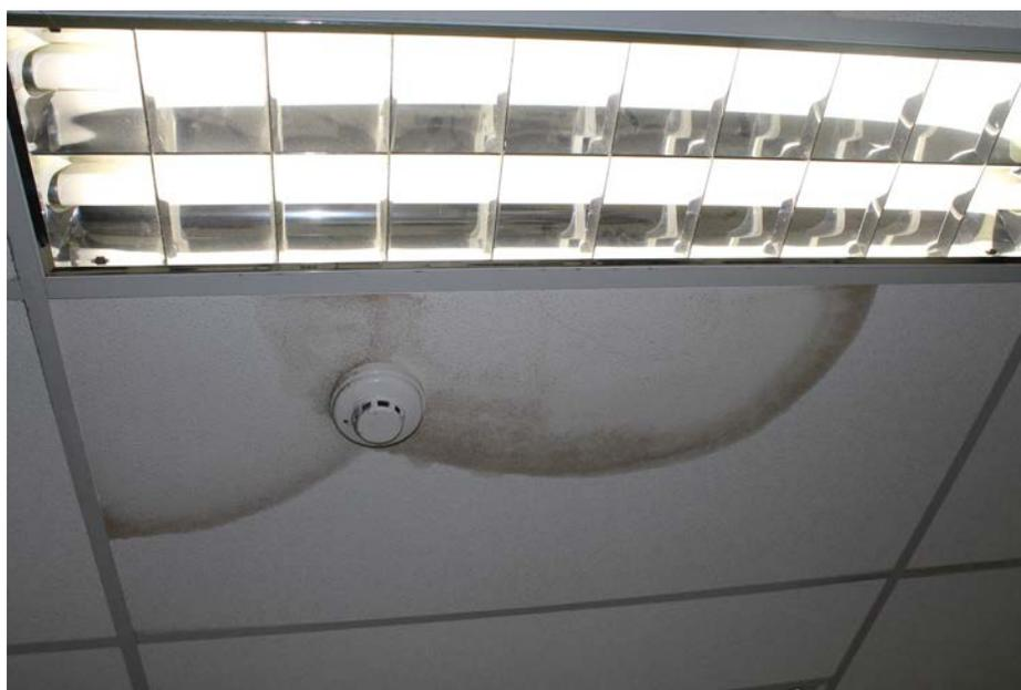
*Imagem 123: Mancha no teto da sala provocada por goteira e sensor de fumaça.*
