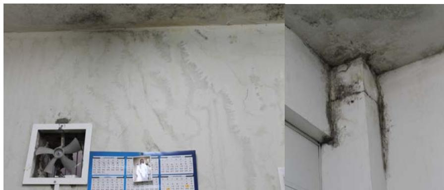
Imagem 21: Marcas de infiltração na sala dos setores da Divisão de Processamento da Identificação Civil.
