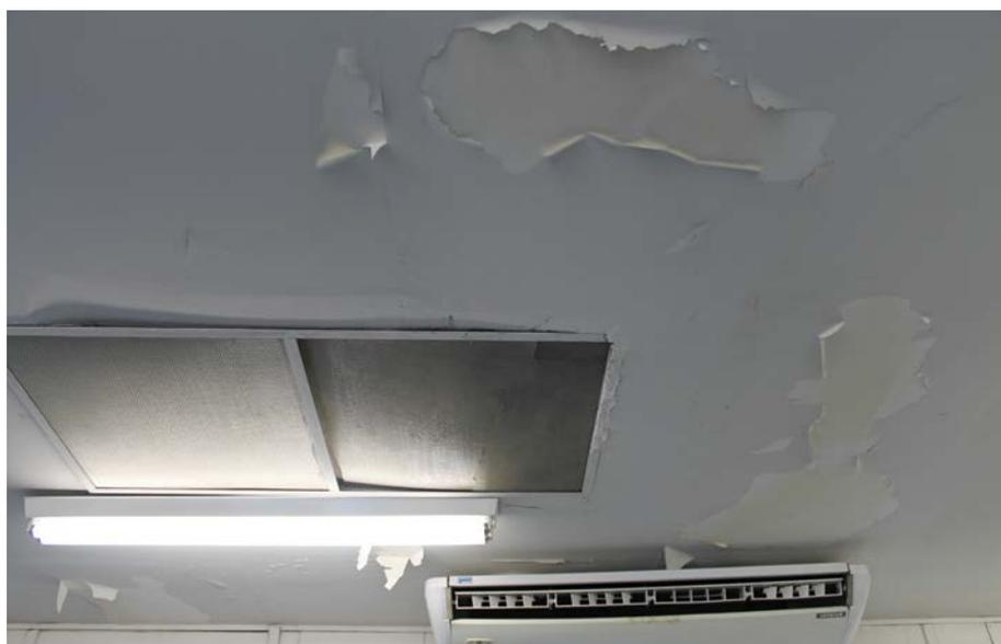
*Imagem 228: Detalhe do ar-condicionado split e teto com pintura descascada.*
