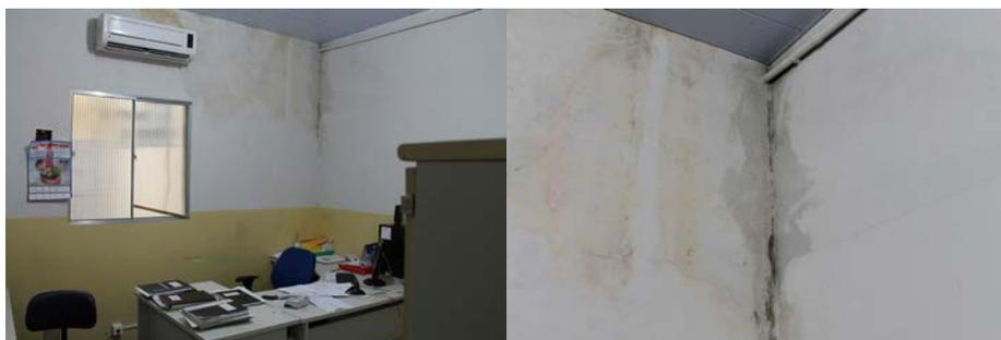
*Imagem 363: Sala da chefia do setor, que possui sinais de infiltração nas suas paredes.*
