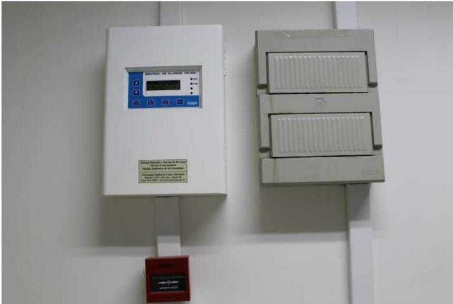
Imagem 121: Sistema de alarme existente no setor.
