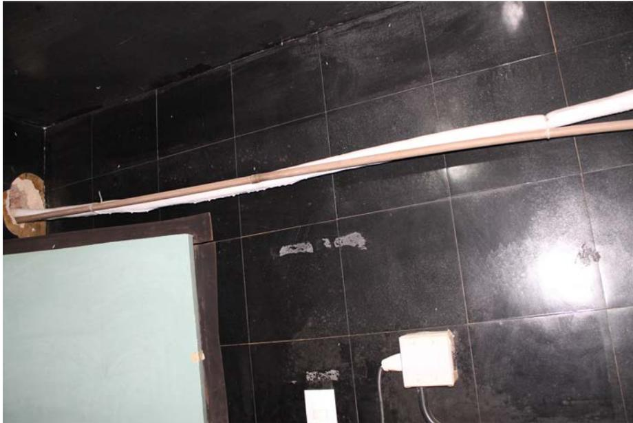
Imagem 347: Encanamento improvisado para coleta da água liberada pelo ar-condicionado.
