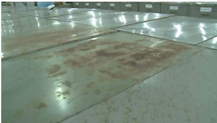
*Imagem 111: Marcas de ferrugem provocadas nos arquivos metálicos devido ao contato com a água das goteiras.*
