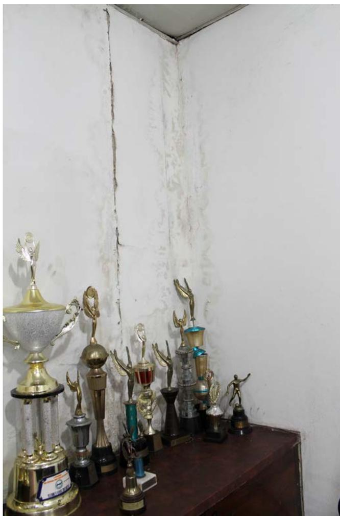
*Imagem 56: Detalhe de infiltração na parede ao fundo do Auditório.*
