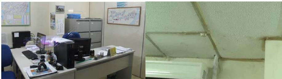
Imagem 49: Sala da Divisão de Processamento da Identificação Civil com teto de isopor vedado por fitas adesivas (direita).
