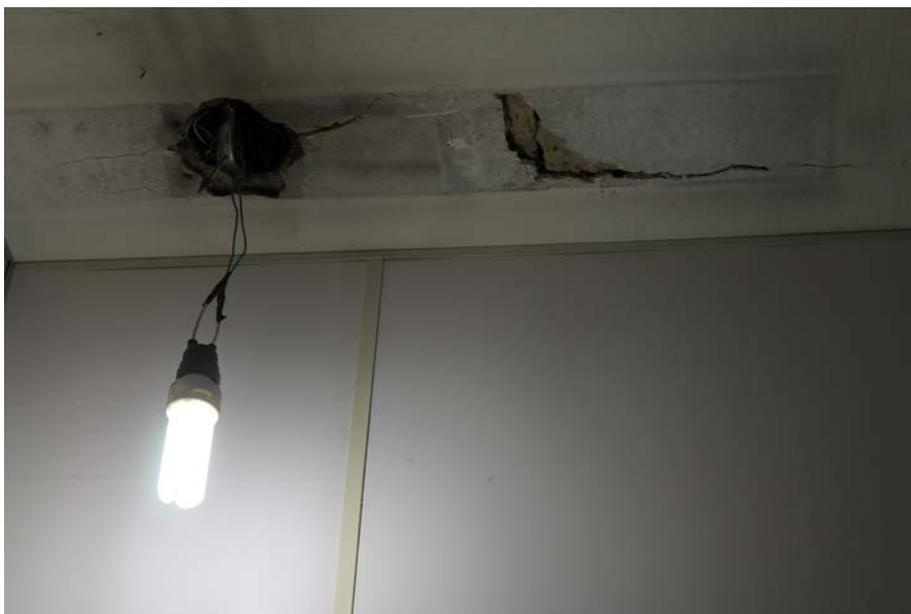
*Imagem 42: Iluminação alta, e com instalação elétrica precária, é compensada pela luminosidade externa das vidraças e do saguão. Nas dependências da seção, encontra-se rachadura na laje que sustenta o primeiro andar.*
