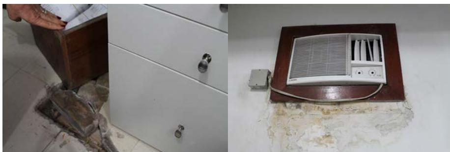
*Imagem 41: Sob uma mesa, pedaços soltos do concreto do piso (esq.). Sob o ar-condicionado, marcas de infiltração de água.*
