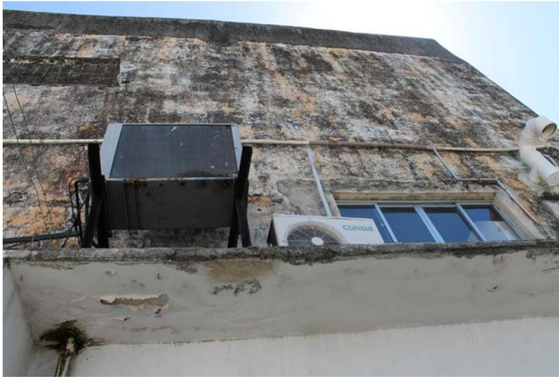
Imagem 76: Laboratório do Rastro visto da área externa lateral do Instituto Tavares Buril. À direita da imagem, identifica-se a chaminé pela qual as substâncias utilizadas na capela de exaustão são liberadas no ambiente externo.
