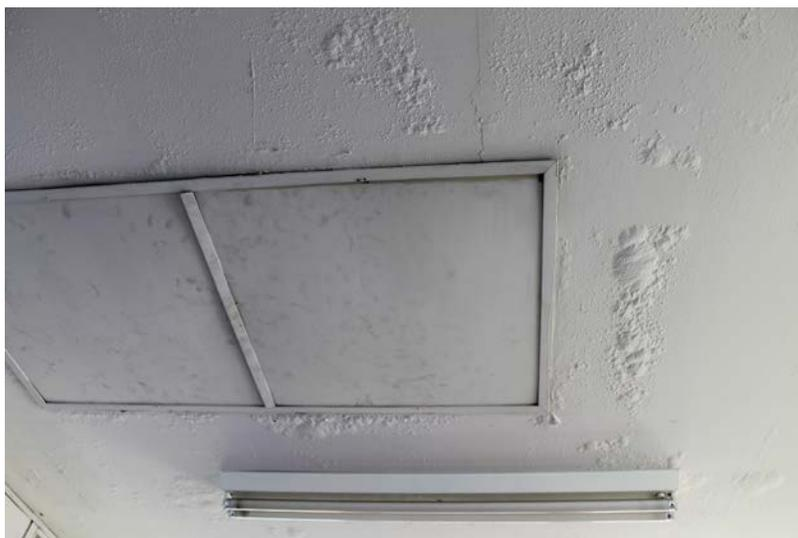
*Imagem 161: Sinais de infiltração no teto de gesso.*
