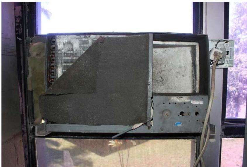
*Imagem 178: Condições de conservação do ar-condicionado da sala e a tomada em que é ligado.*
