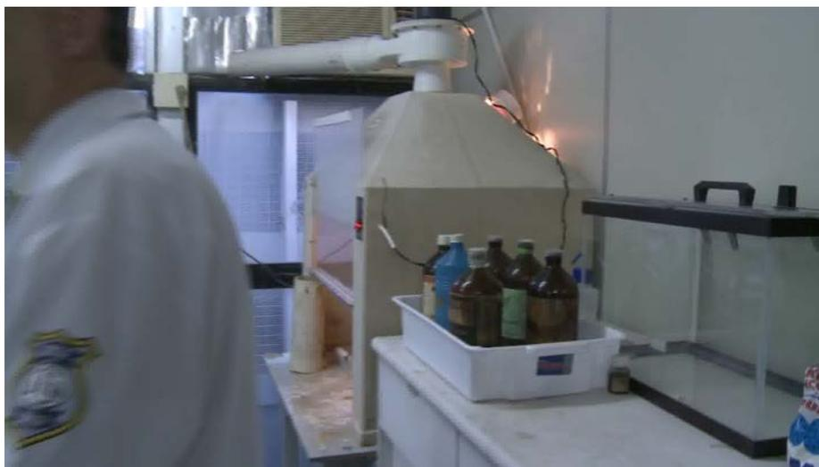
*Imagem 277: Capela existente no laboratório químico do IC não supre as necessidades de segurança contra contaminação e instalação de uma outra nova. Implicaria ajustes na estrutura física.*
