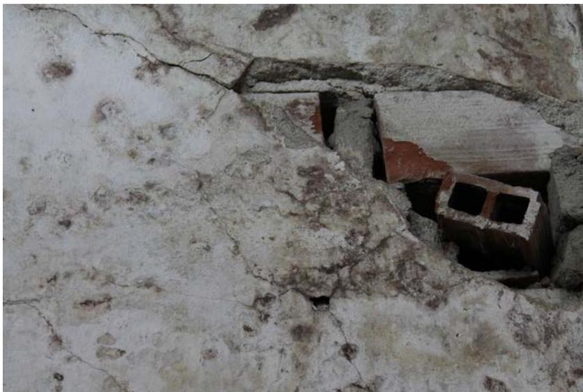
*Imagem 109: Buraco na parede do arquivo civil com tijolos expostos.*
