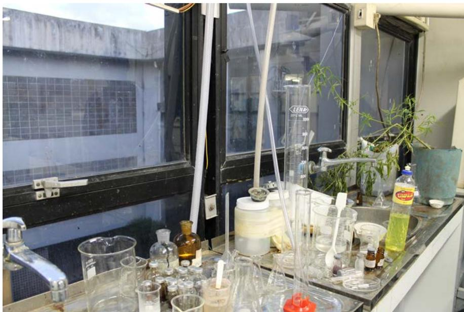
*Imagem 276: Pia na qual materiais químicos são descartados não é ligada a esgoto especial que minimize contaminação ambiental.*
