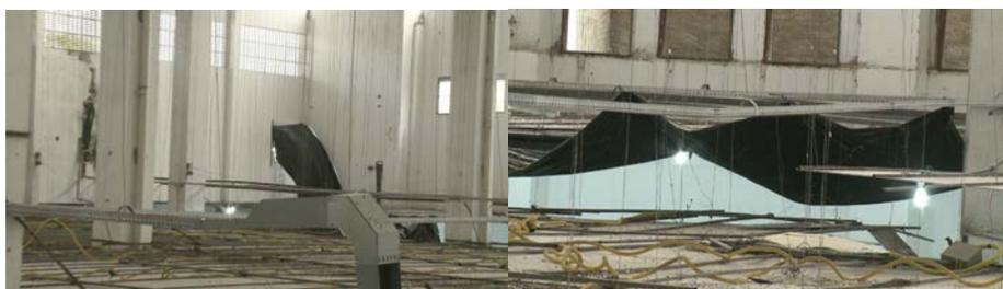
*Imagem 65: Detalhes do teto das instalações do arquivo. Conduítes e fios metálicos que dão sustentação ao forro ficam mais evidentes. À esquerda, abertura na parede coberta por plástico preto, que também existe na cobertura de falhas do teto.*
