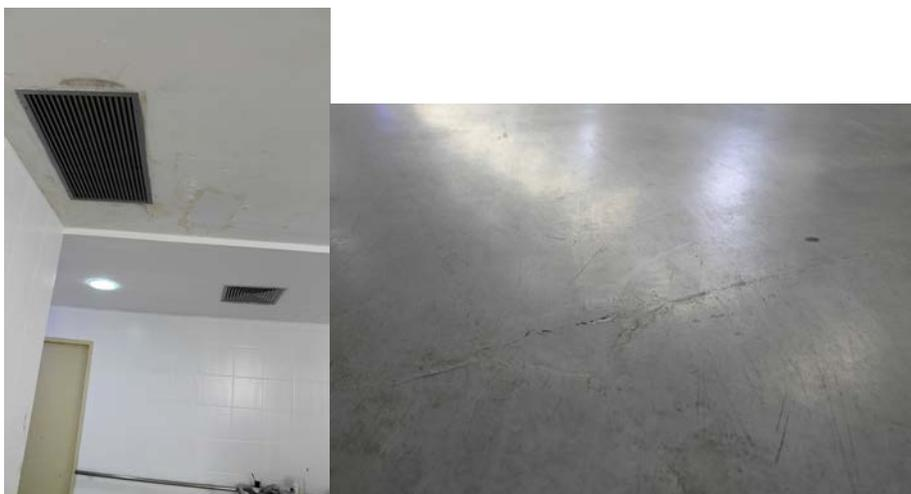
*Imagem 291: Buraco do sistema de exaustão do ar da sala. À direita, detalhe do piso coberto com tinta lavável.*
