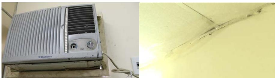
Imagem 45: Aparelho de ar-condicionado da sala da Uticrim apresenta instalação precária. À direita, vãos e rachaduras do teto de gesso são vedados com fitas adesivas.
