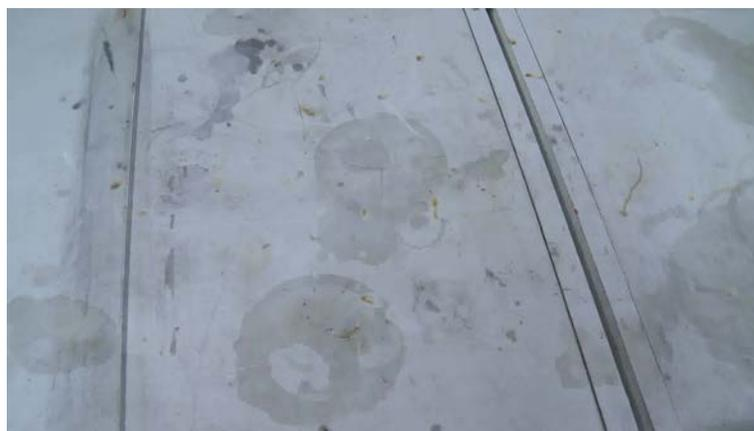
*Imagem 274: Marcas existentes nos balcões são consequências do acúmulo de substâncias químicas na madeira.*
