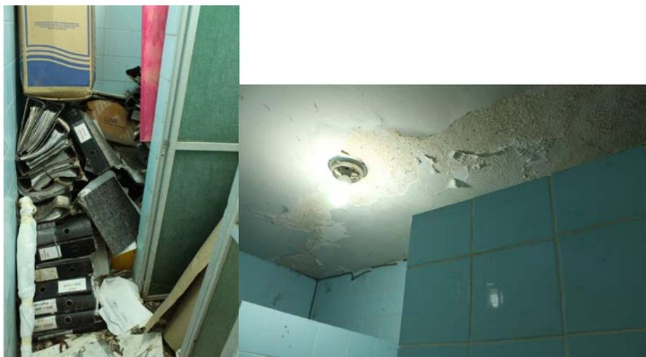
*Imagem 354: Banheiro utilizado para armazenar arquivos com sinais de infiltração de água no teto.*
