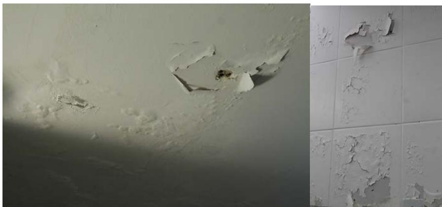
*Imagem 292: Marcas de infiltração no teto e pintura descascada nas paredes da sala.*
