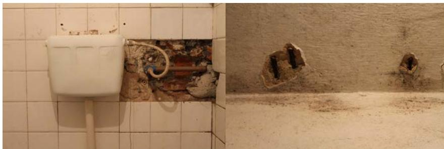
*Imagem 88: Buraco entre azulejos e ferragens da laje expostas no teto do banheiro do Setor de Necropapiloscopia.*
