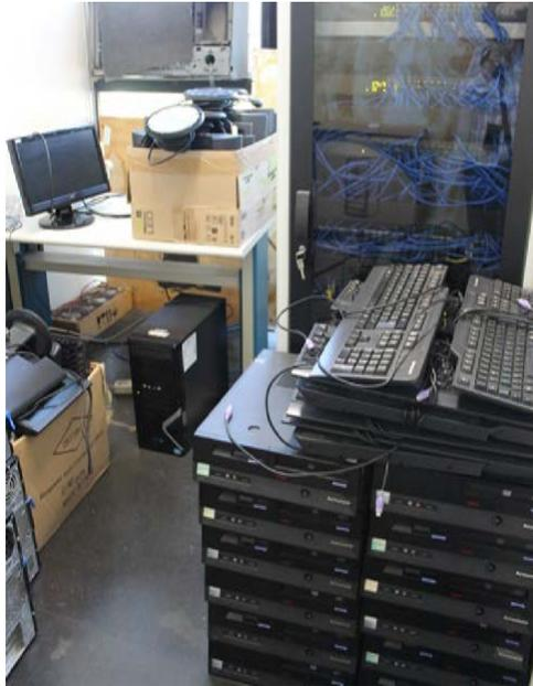
*Imagem 232: Local no qual a infraestrutura de rede do Instituto está instalada. Há ainda diversos aparelhos empilhados no chão do local. De acordo com o mapa de riscos, aqui é um lugar de alto risco de acidentes elétricos.*
