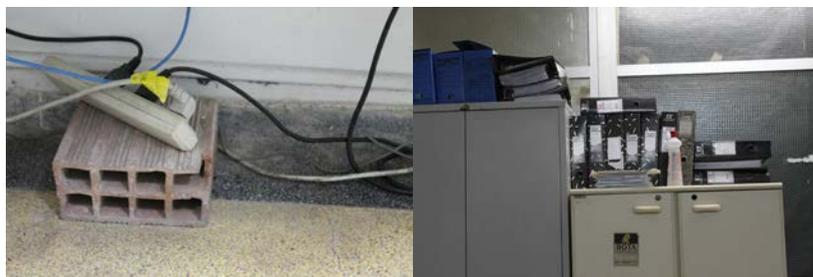
Imagem 86: À esquerda, tijolos improvisados como apoio para aparelhos da instalação elétrica dos computadores. À direita, armários e pastas existentes no setor.
