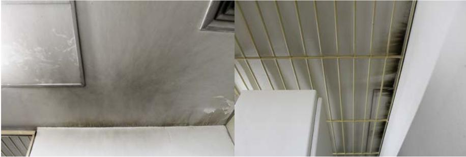
*Imagem 215: Marcas de fogo no teto produzidas por incêndio ocorrido na sala de disparos.*
