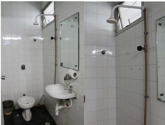
*Imagem 157: Banheiro do alojamento feminino e instalação do chuveiro com encanamento externo*
