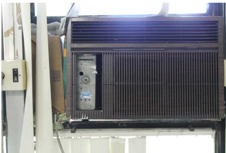
Imagem 155: Detalhe do ar-condicionado danificado existente no escritório.
