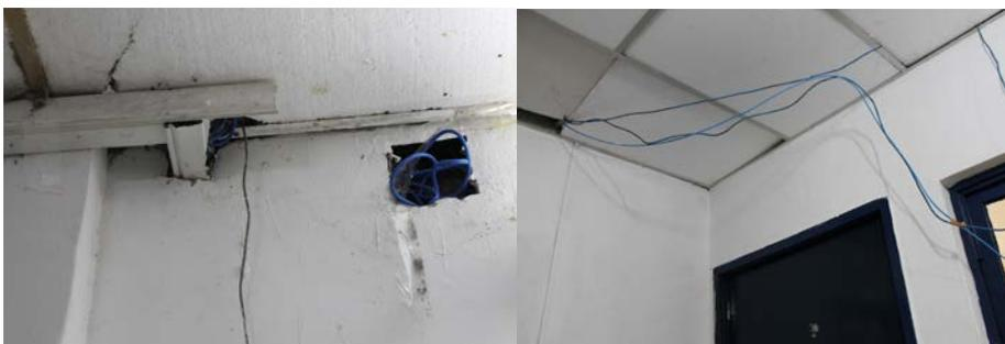
*Imagem 27: Tetos de isopor com vãos acabam facilitando a passagem de fios.*
