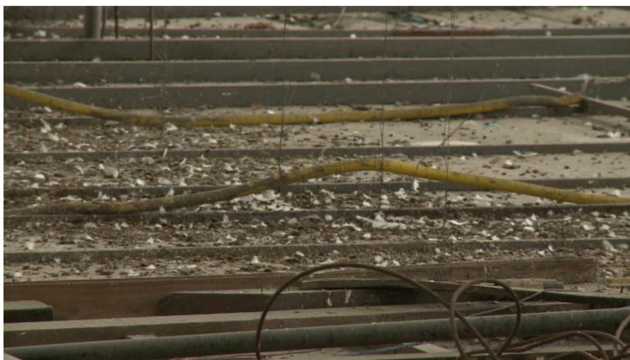
*Imagem 62: Sujeira formada por fezes e penas de pombos se acumula com o tempo sobre os forros dos arquivos do Instituto Tavares Buril e se constitui em focos de contaminação e ameaça à saúde de seus funcionários.*
