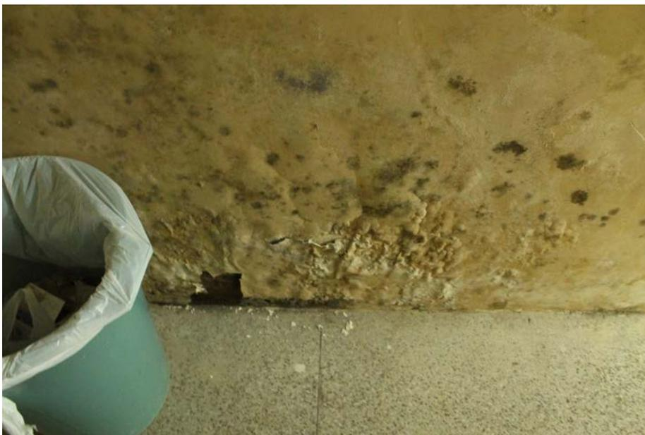
*Imagem 372: Paredes têm seu reboco estofado e bolor, devido à infiltração de umidade.*
