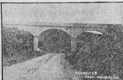
Aquedutos para serviço de irrigação dos morros
