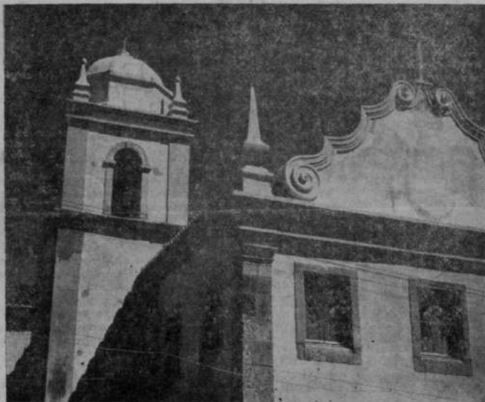
FACHADA DA CONCEIÇÃO DAS DOROTEIAS: AQUI ANDOU O DEDO DO S. P. H. A. N., CORRIGINDO E PRESERVANDO
