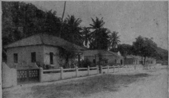
Vista parcial da Vila dos Ferroviários em Piranga
