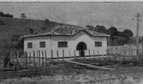
Construção de um posto médico, em um conjunto de 12 iguais em diversos engenhos.
