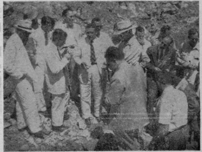
Os congressistas em visita às jazidas de calcário da Fábrica de Cimento Poti
