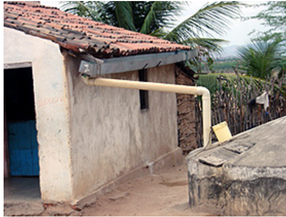
Cisterna construída em aldeia indígena
