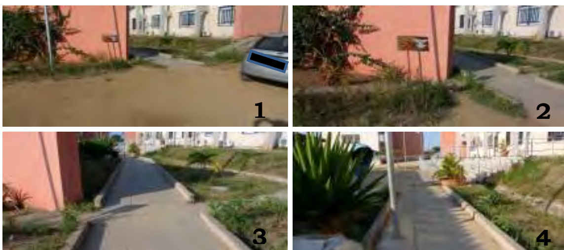
Fotografia 3 - Vaga reservada para veículos que conduzam ou sejam conduzidos por pessoas deficientes. Legenda: 1. Vaga reserva; 2. Sinalização vertical/ início da rota acessível (lado direito); 3 e 4. Rota de acesso a partir do estacionamento. Fonte: Ianara Almeida (2013).
