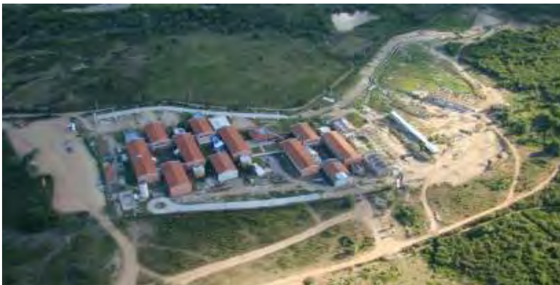
Fotografia 1 - Vista aérea do Centro Acadêmico do Agreste em construção no seu espaço definitivo. Fonte: www.ufpe.br/caa/index .
